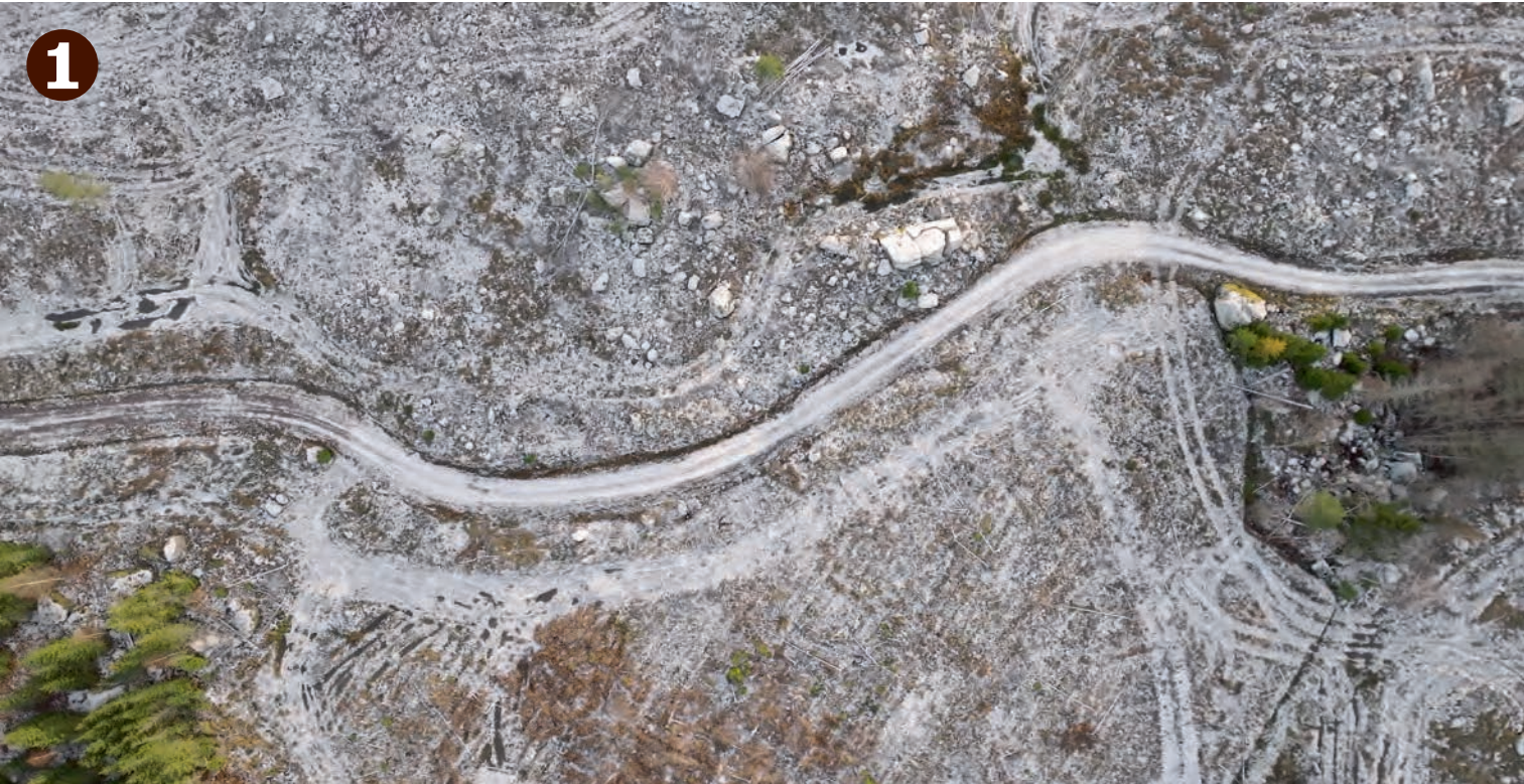
Vägen är byggd med en för liten grävmaskin som inte klarar större stenar, så vägen är krokig. Det ger större slitage och långsam körning. Större stenar intill vägen bäddar för ineffektiv buskröjning.
