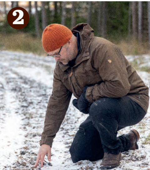
Bygget är underfinansierat, framför allt är gruslagret alldeles för tunt. Det är produktionssidans privilegium att tvingas köra sönder vägar om man måste ha fram råvara, men det blir mycket värre och dyrare skador om man inte gjort rätt från början.
